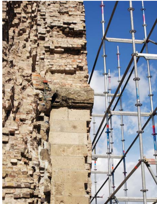
Herbst 2010: Der Gerüstaufbau hat begonnen
