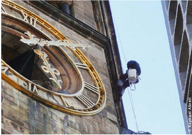
Fassadenkletterer bei der Bestandsaufnahme
